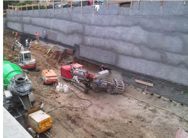
Foto 7: Herstellung Dauervernagelung
