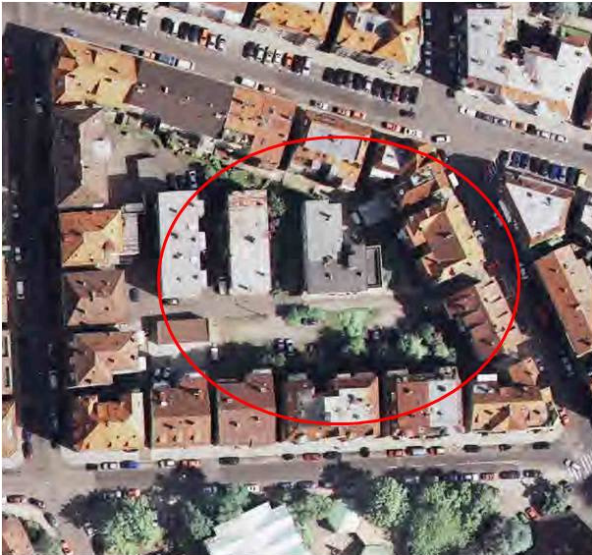
Foto 4: Luftaufnahme Quartier „Rossbollengässe“
