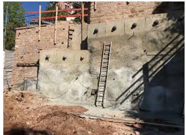
Die Ausführung dieser Konstruktion bis auf Höhe der Baugrubensohle war nicht möglich, da auf der Westseite des Baufelds eine Rückverankerung nicht gestattet war.
