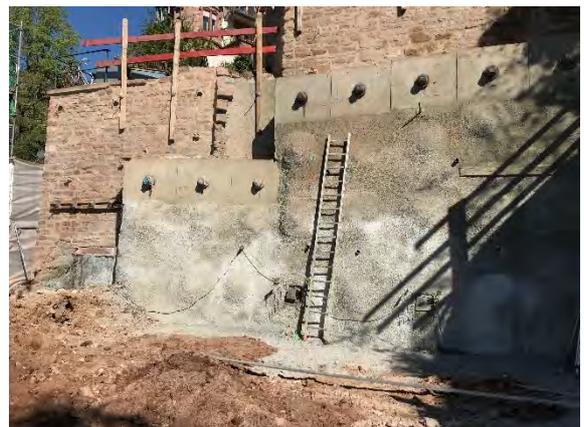
**Abbildung 21:** Blick Richtung Norden, links Schutzbermen vor Steifeneinbau
