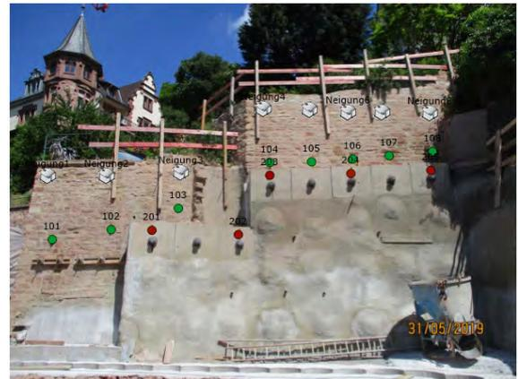
**Abbildung 24:** Beispielhaftes Ergebnis der Setzungen der Natursteinmauer mit farbiger Darstellung Warn- und Alarmwert (grün, gelb)
