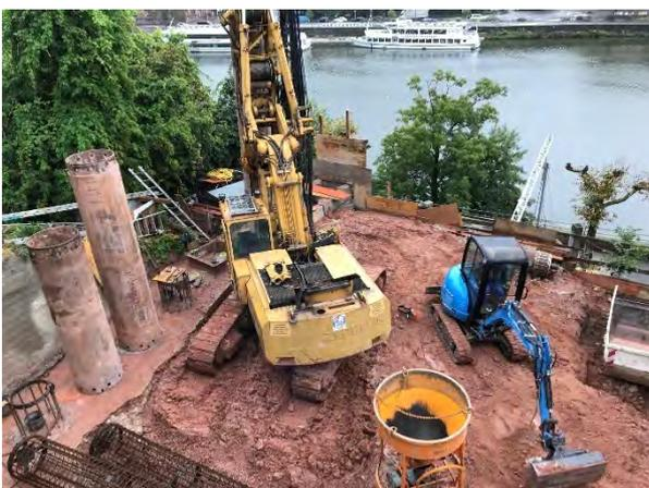
**Abbildung 19:** Ankerbohrgerät Beretta T44 vor der südlichen Stützmauer auf Endaushubsohle
