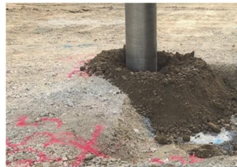
Abbildung 9: Baustelle - Aufwölbung während des Eindringprozesses bei der Herstellung eines Schraubpfahls
